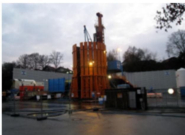
*Sowohl bei den seismischen Messungen, als auch beim Anlagenbau werden die erforderlichen Lärmschutzmaßnahmen getroffen. Hier ist die Lärmschutzwand bei den Bohrarbeiten in Waldkraiburg zu sehen.*
