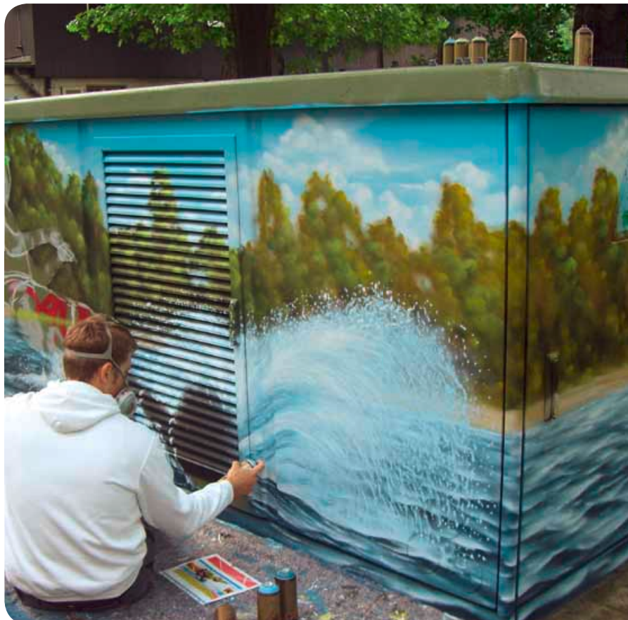
Ein Sprayer besprüht eine Netzstation der Stadtwerke Duisburg.
